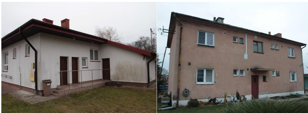
Zdjęcie 2. Obecny wygląd przedszkola komunalnego i budynku SKR w Szczurowej
